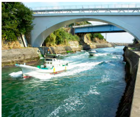
Fukaya canal 深谷水道
