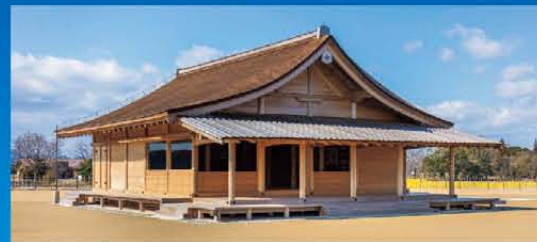
東脇殿 南北に長く、床を張らず、南北方向には壁もない建物であったとみられています。儀式の前に斎宮寮の役人が待機したり、儀式の準備に使われたと考えられています。
